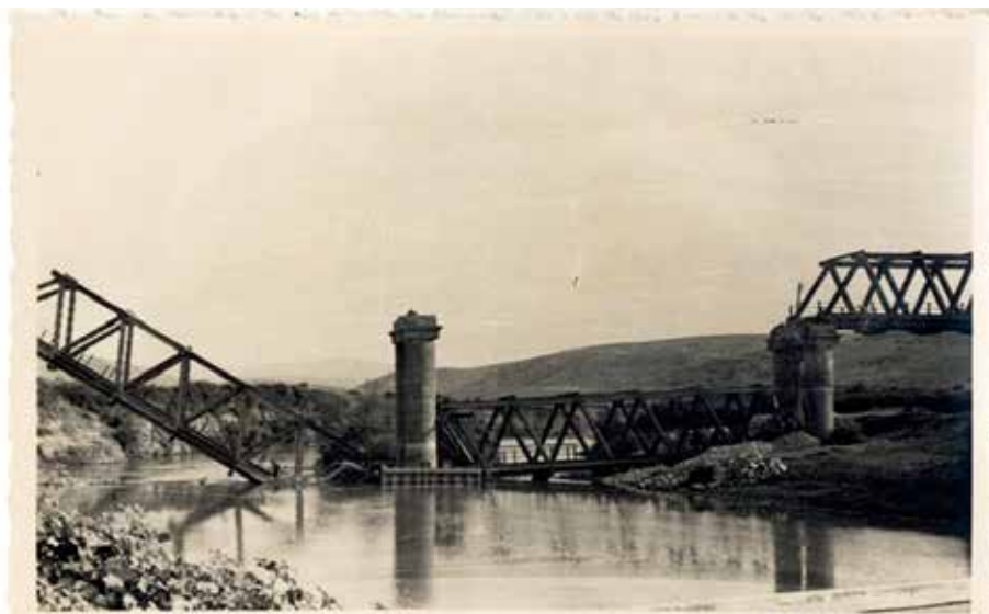
10-VII: ponte sul Reno fra Triccala e Larissa, distruito dagli inglesi
