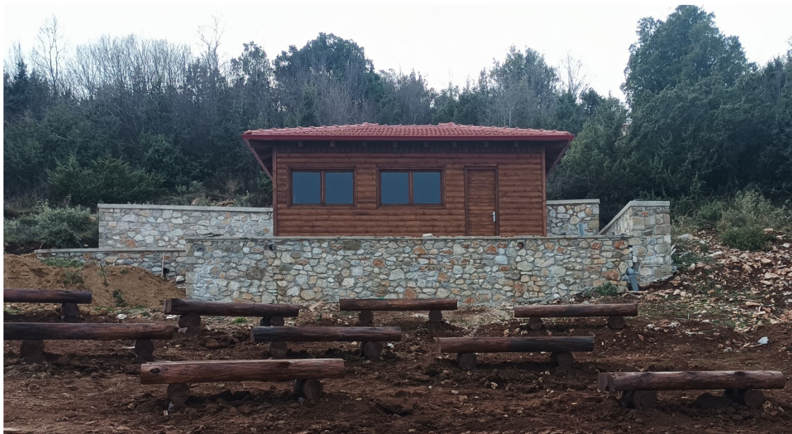
Ολοκληρωμένο το αναψυκτήριο και ο χώρος εκδηλώσεων, υποέργο της α φάσης
