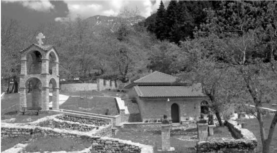
ΕΙΚ. 1. Ο ναός της Αγίας Παρασκευής (δεξιά) στη θέση Γούβα των Βραγγιανών Ευρυτανίας και αριστερά τα ερείπια των κτιρίων όπου είχε λειτουργήσει το "Ελληνογymnasium Βραγγιανών" (Φωτ/φία Άγγελου Σινάνη).
