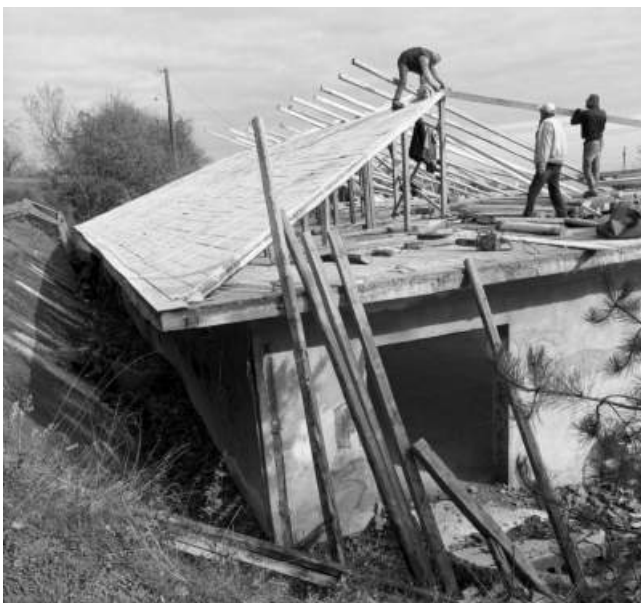
Εργασίες ανακατασκευής του κτιρίου Γυμνασίου Μεσενικόλα για μετατροπή σε Ιστορικό Μουσείο (2025)
