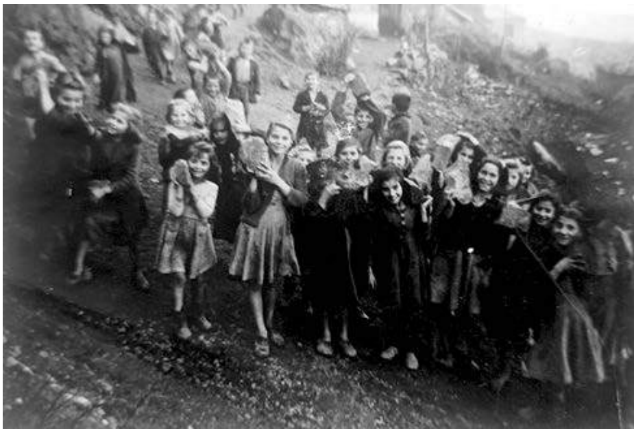
Αγόρια και κορίτσια του Δημοτικού Σχολείου Μορφοβουνίου μεταφέρουν πέτρα, με την οποία κτίστηκε ο τοίχος του προαυλίου του σχολείου περίπου 1953, φωτ. αρχείου Παναγιώτη Νάννου.
