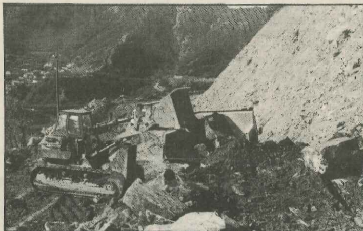
Από τις εργασίες στην οδική αρτηρία Καρδίτσας - Νεράϊδας (Δολόπων).
