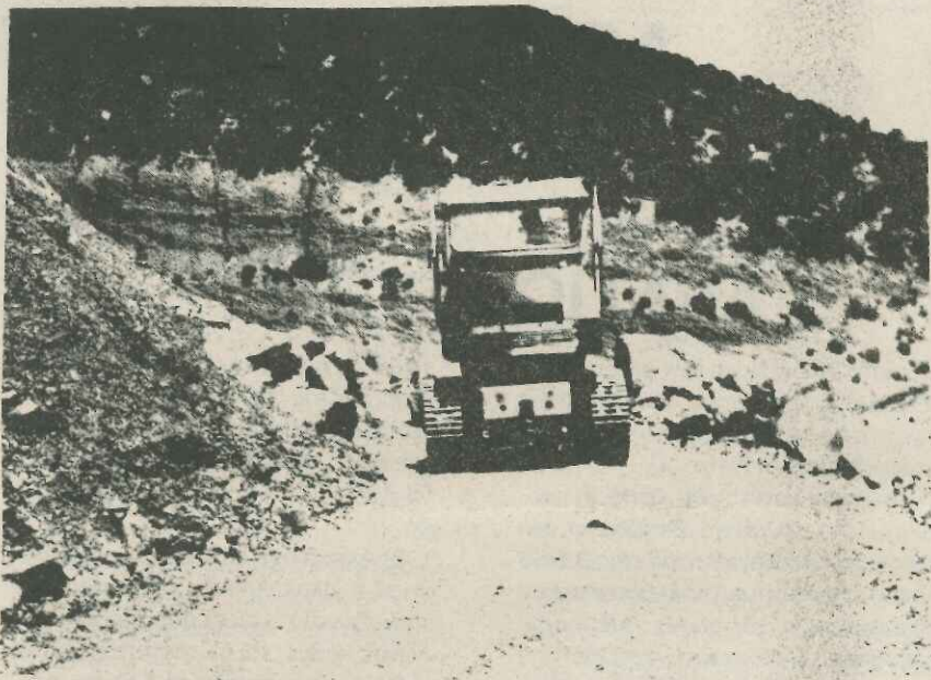
Κατασκευάζεται ο δρόμος Καρδίτσας - Αγρινίου.
