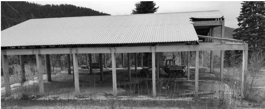
Το ξυλουργικό εργοστάσιο Φουρνάς που εγκαταλείφθηκε. Φ. από Β. Τσαντίλα 2022
